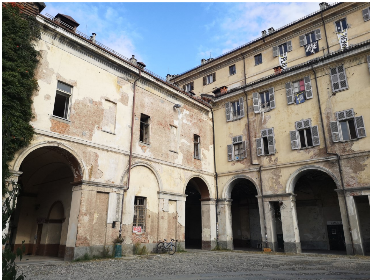
Torino, Complesso della Cavallerizza, Manica del Mosca, fronte su piazzetta fratelli Vasco, 2022
